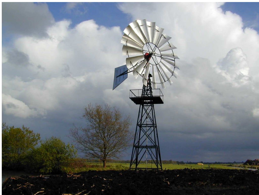
Windmotor roosdiameter 5 m1 torenhoogte 7,5 m1
