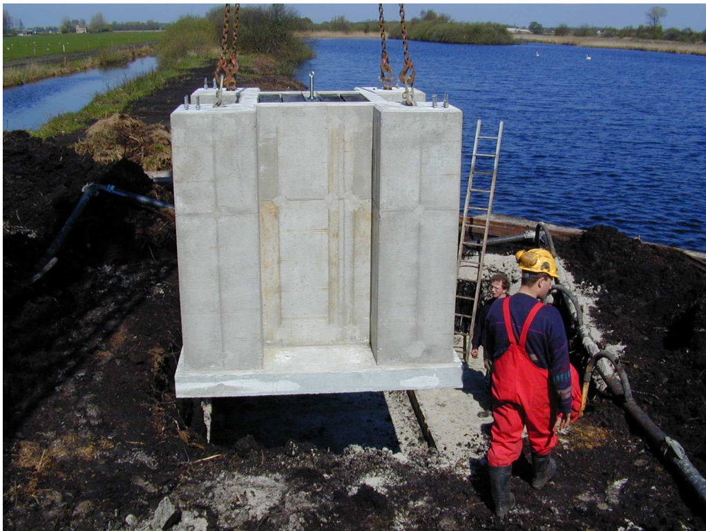
Pompput wordt prefab klaar gemaakt en compleet met pomp opgesteld in het veld, fundering kan bestaan uit houten kessen, en een kwelscherm. Aanvoer en afvoer water doormiddel van PVC buizen.
